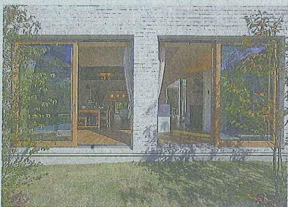
共同開発した木製サッシの施工例
